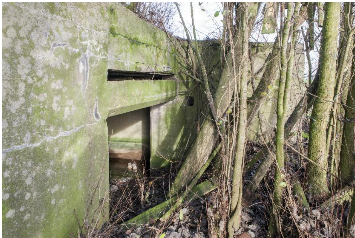
Élévation sud-est. L'entrée de la chambre de tir et le double couverture avec sa cellule d'éclatement
