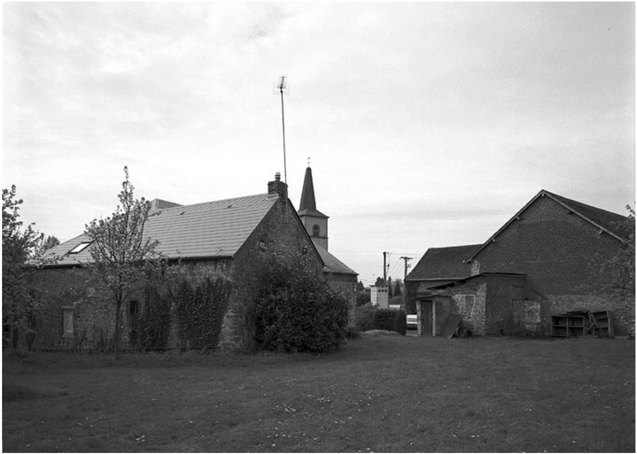
Vue de l'élévation postérieure du logis.
