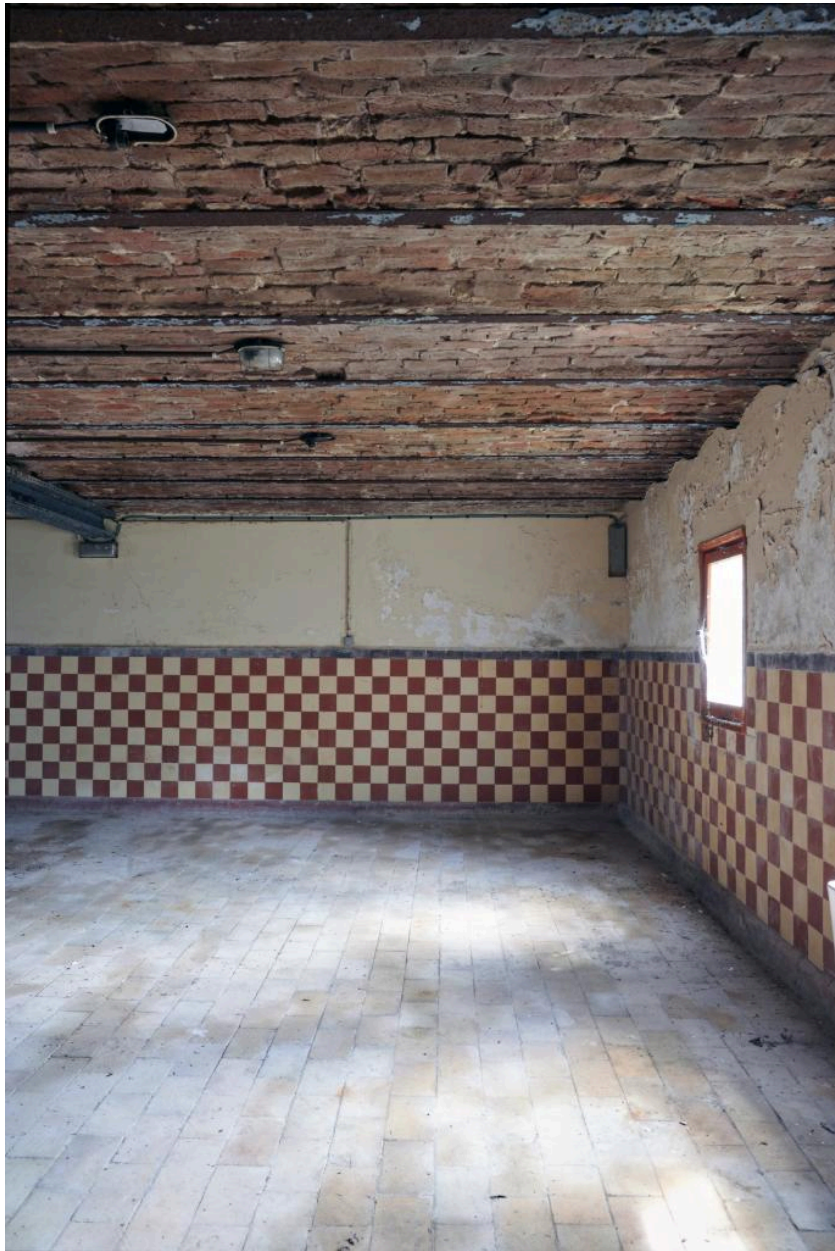
Sous-sol du logement du chef d'élevage.
