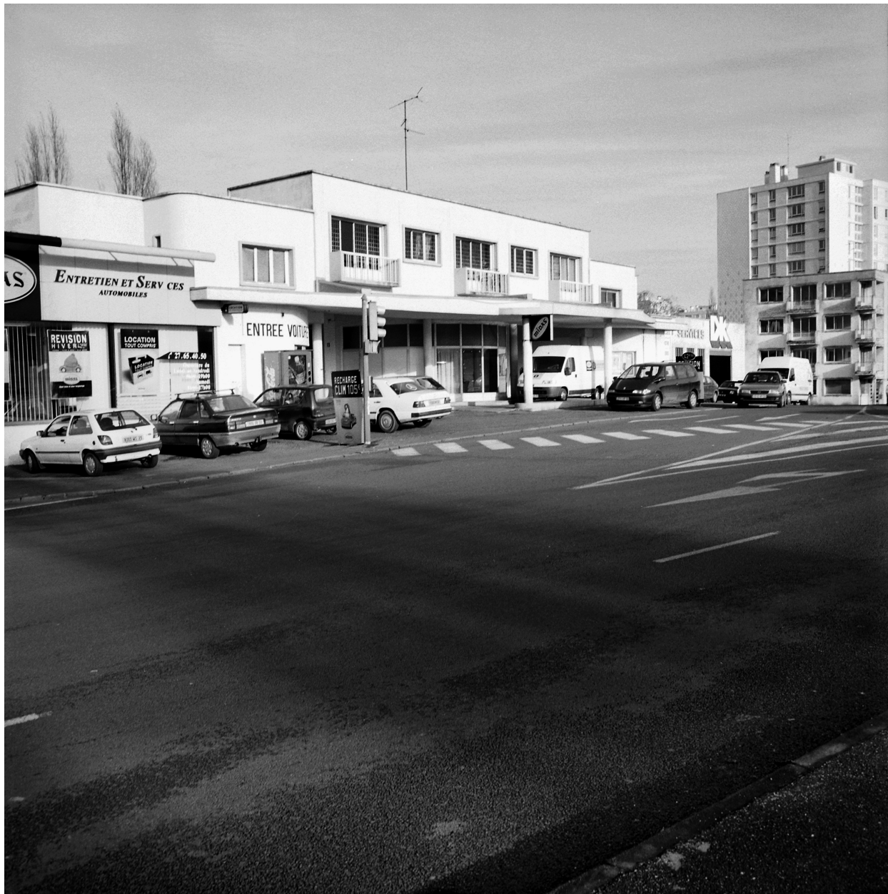
Vue générale du garage.
