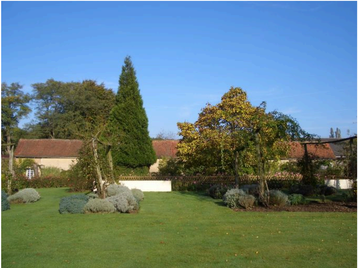
Aperçu des bergeries depuis le sud.
