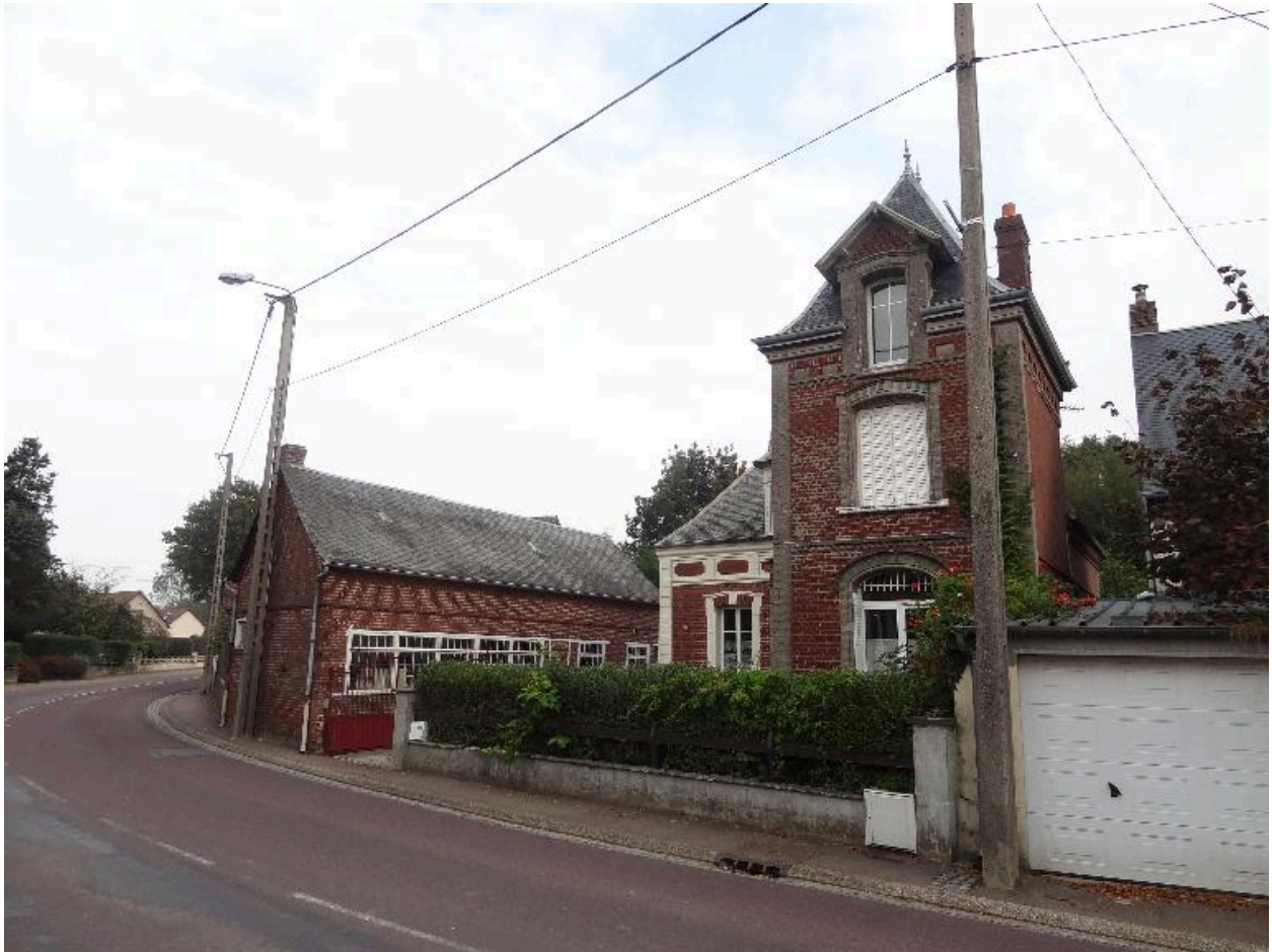
Vue générale, depuis la rue d'Ault.
