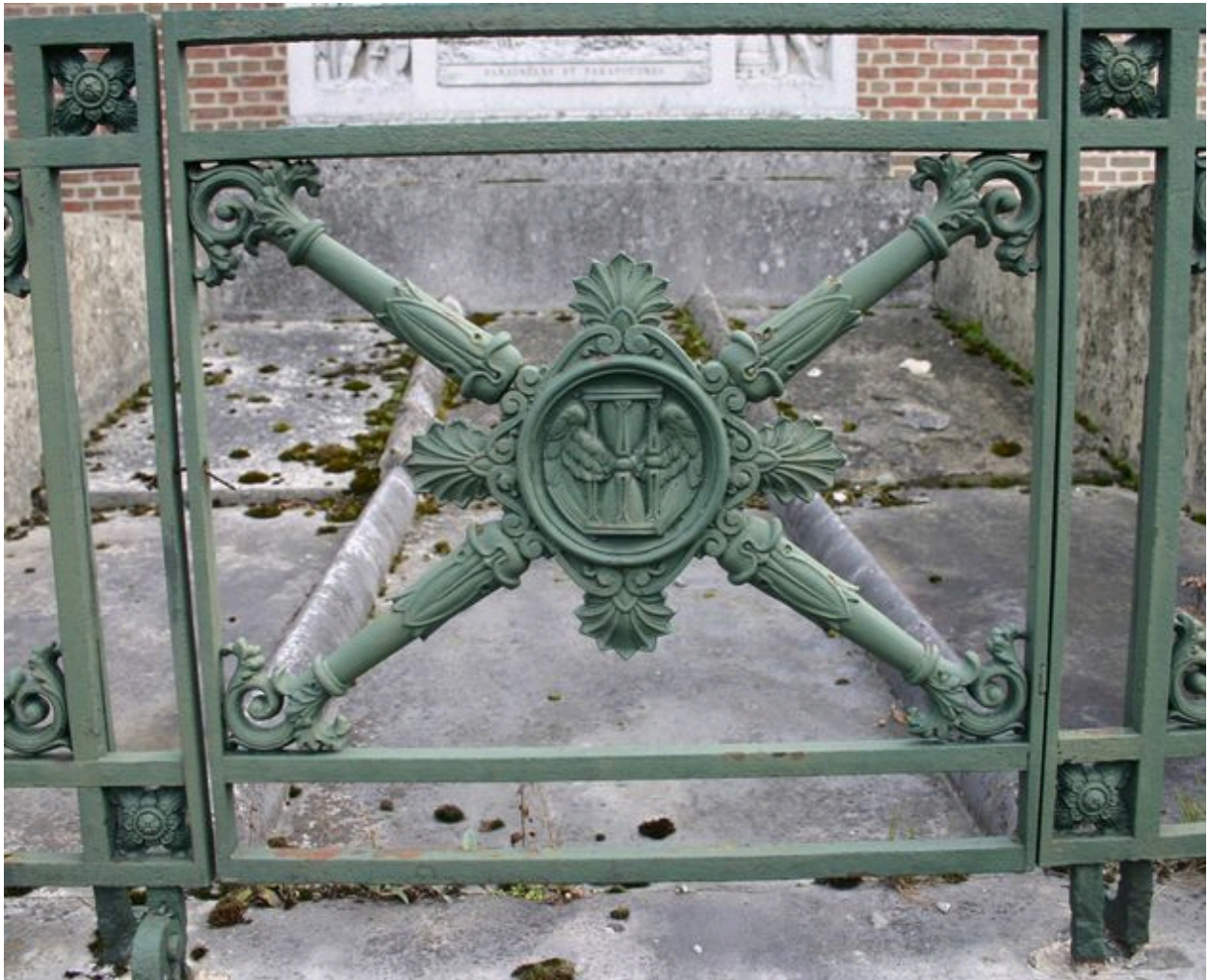
Vantail de la grille en fonte.
