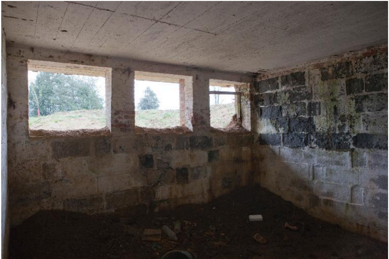
Abri casernement : vue intérieure.
