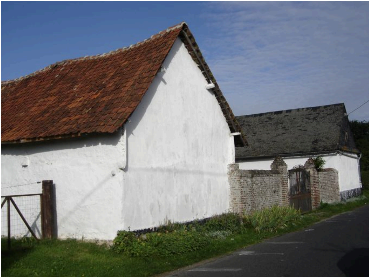
Vue générale de l'entrée de la ferme depuis la rue.
