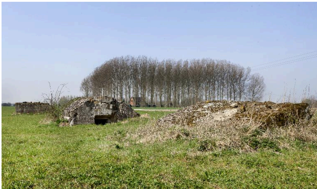
Vue générale des trois casemates, vers l'ouest
