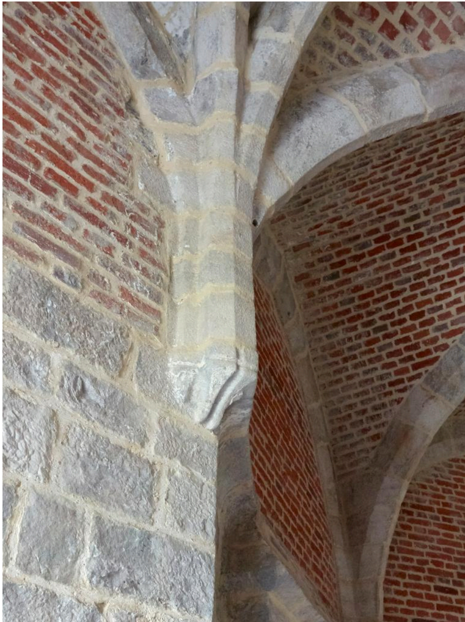
Vue en détail d'un des deux corbeaux moulurés de la voûte du premier niveau.
