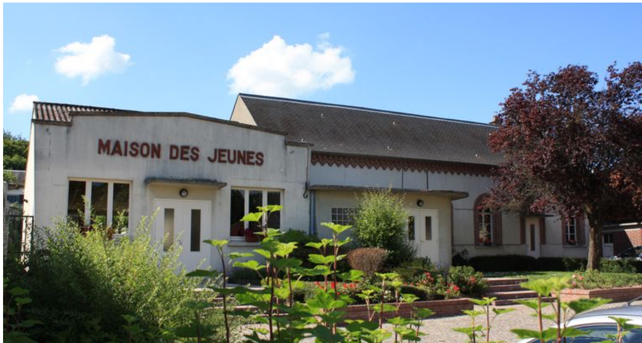
Façade sur rue de l'ancienne école de filles et de la salle des fêtes.
