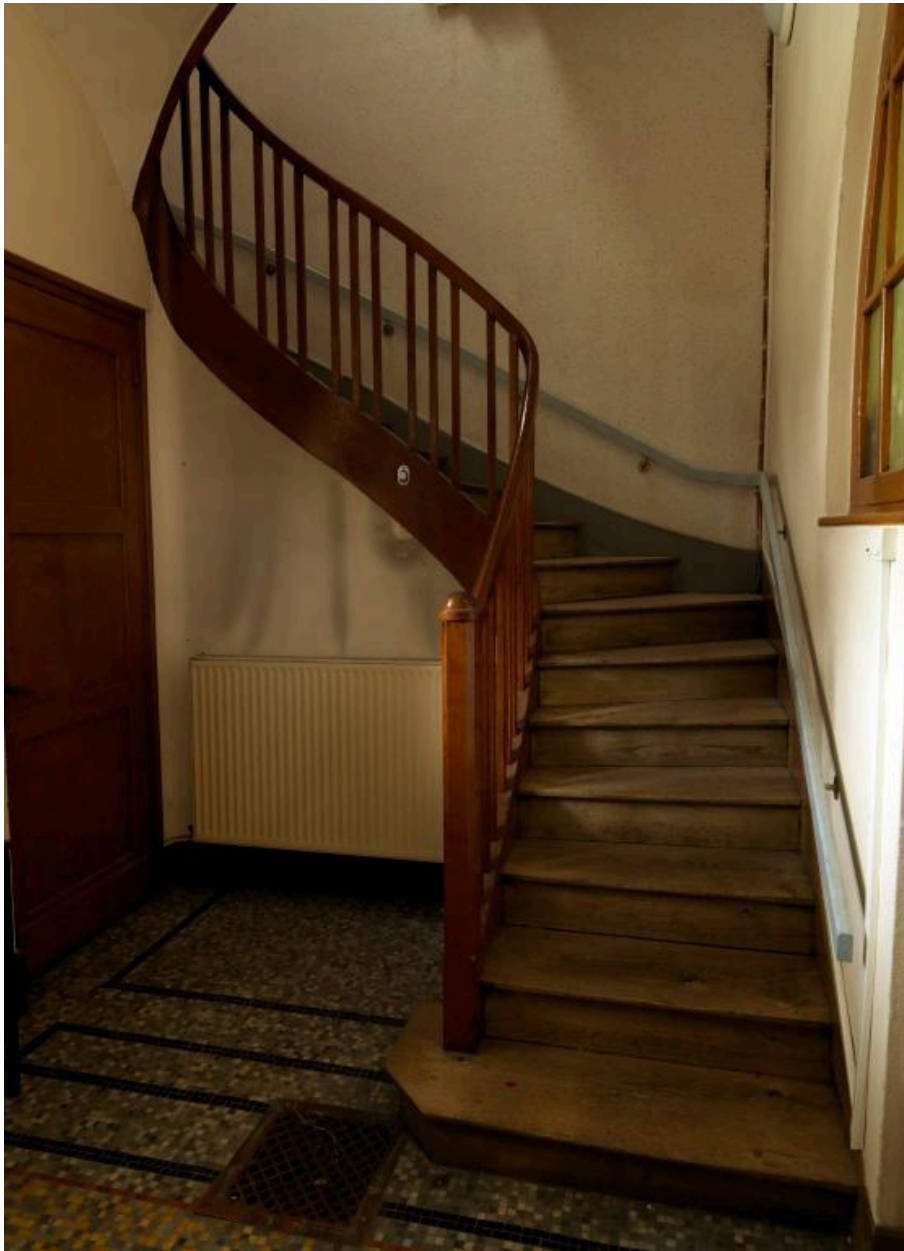
L'escalier menant aux anciens logements.
