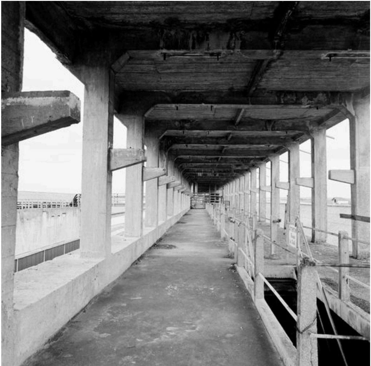
Galerie du pont transbordeur des matières premières.
