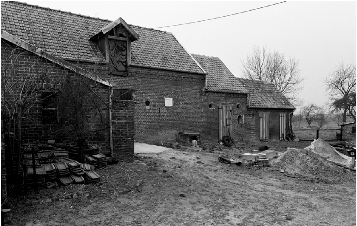
Elévation sur cour des étables et fenil.
