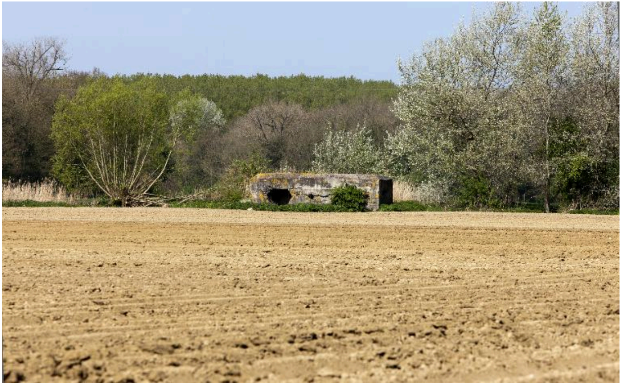
Vue générale vers le nord-ouest
