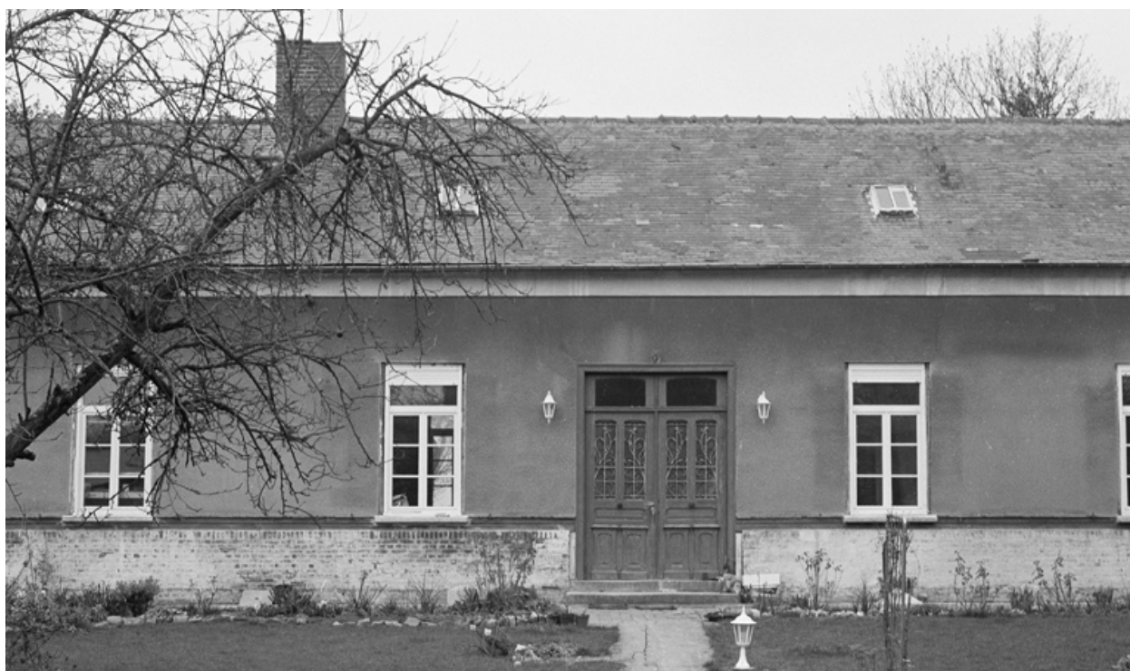
Façade antérieure du logis sur cour.
