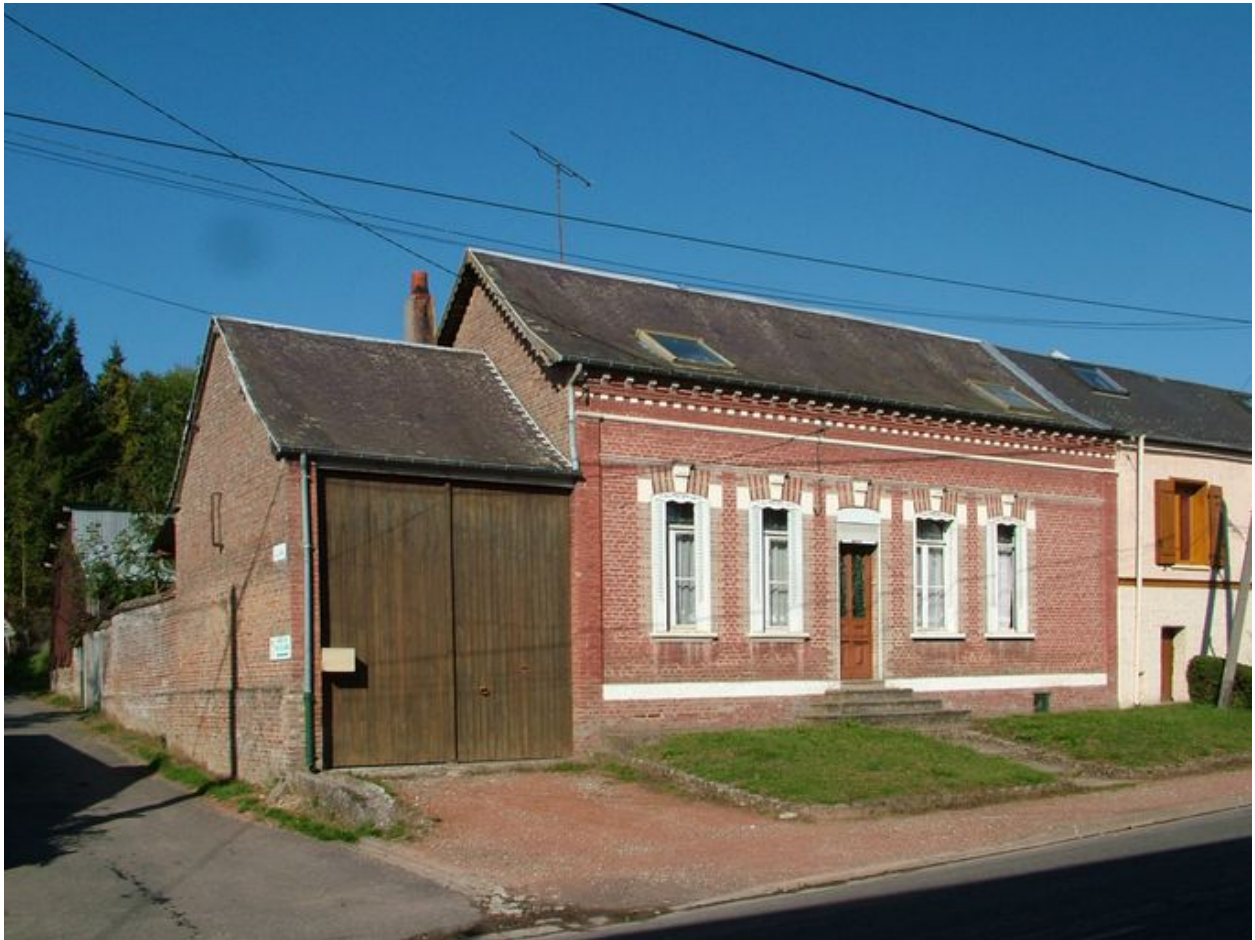
Canaples, maison, 89 rue de Fieffes, dont la façade a été remontée à la fin du 19e ou au début du 20e siècle.
