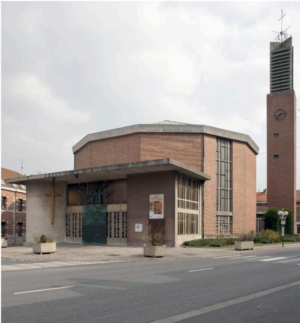
Vue générale élévation antérieure.
