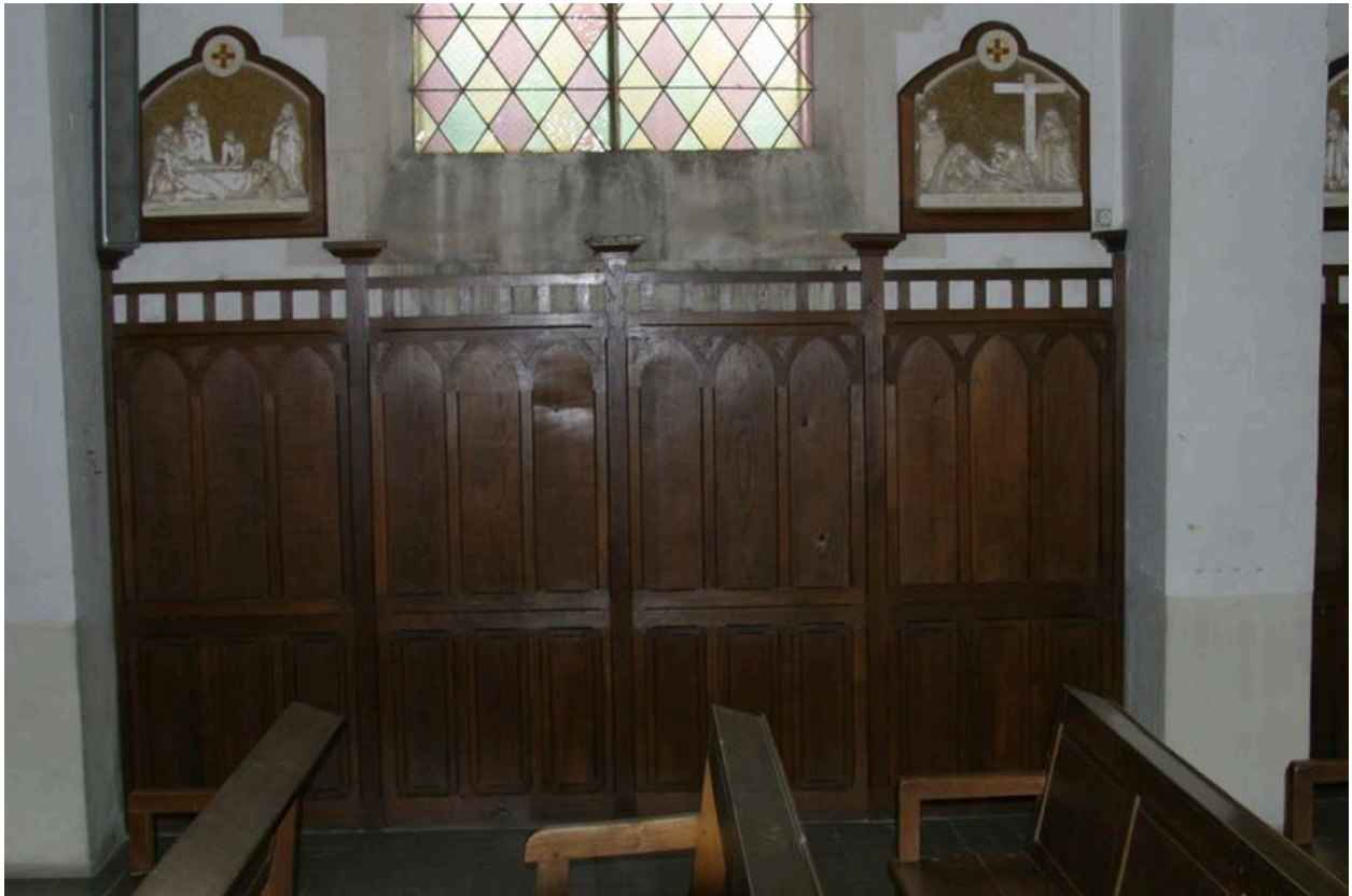
Vue des lambris de demi-revêtements de la nef.
