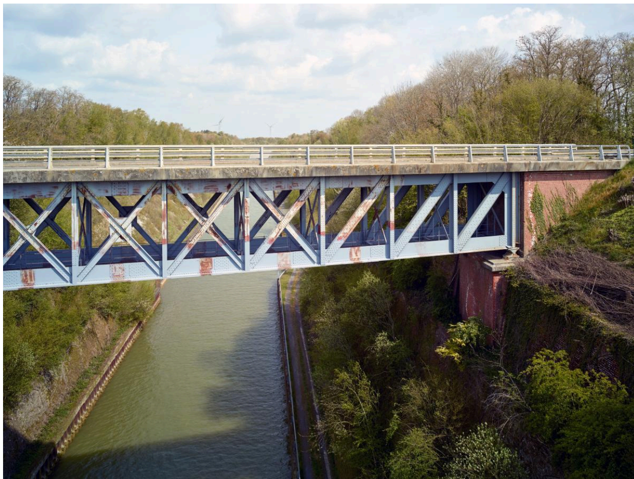
Pont routier nord.
