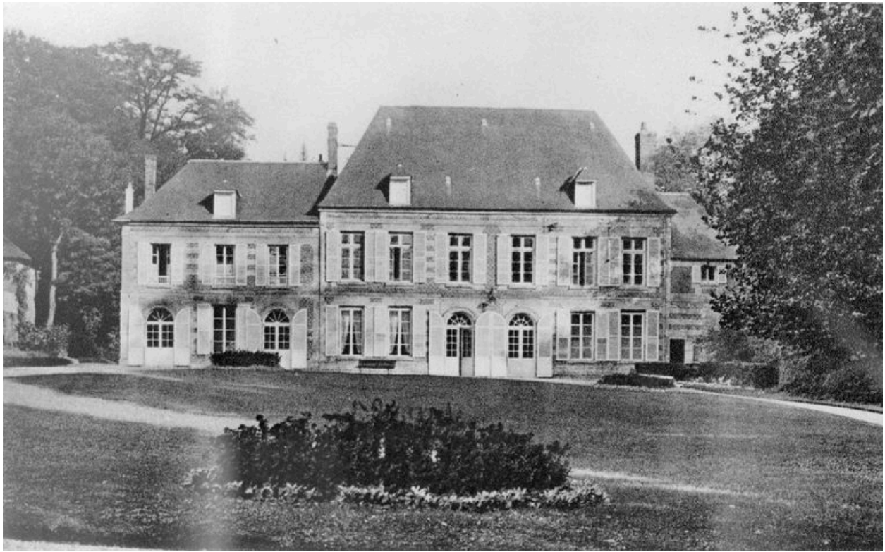
Logis. Elévation antérieure (AP).
