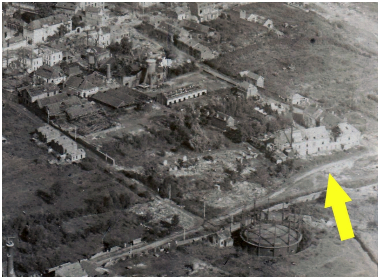
Vue aérienne prise en octobre 1918 (BM Saint-Quentin).
