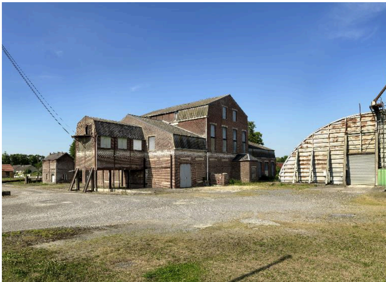
Vue d'ensemble nord-ouest de la râperie.
