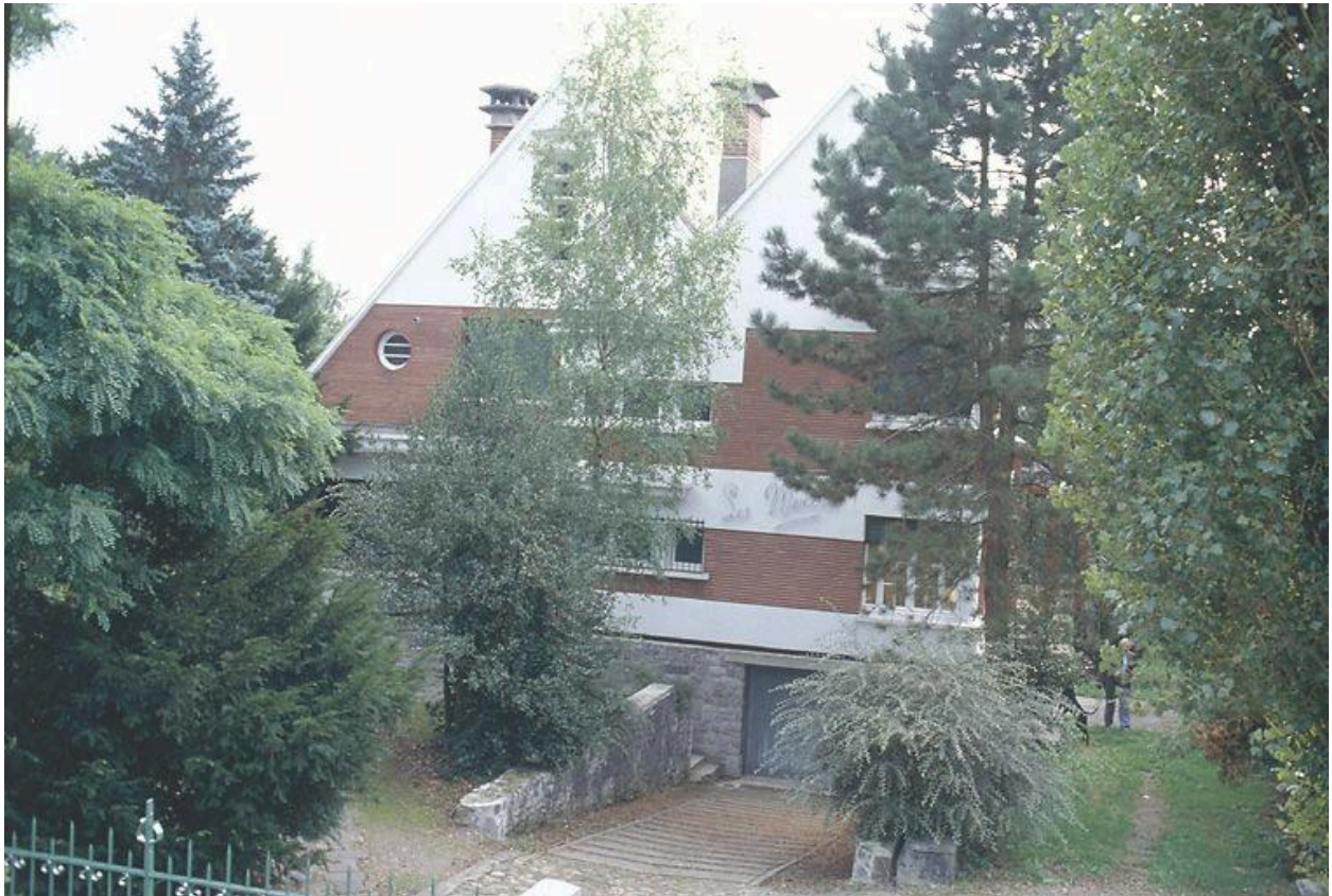
Maison Les Merises sise au n°55 de la rue Deham à Hautmont, construite par Marcel Melon.
