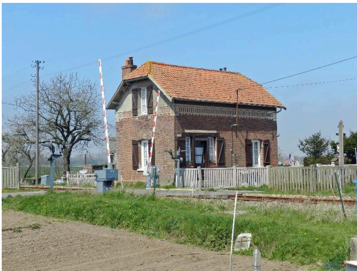
Maison de garde-barrière, rue Camille-Pelletan.
