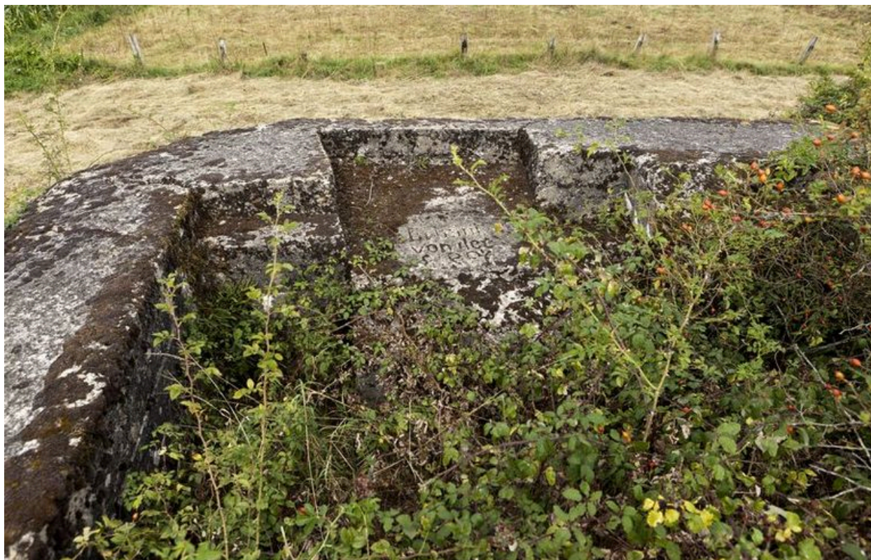
Bâtiment A : Position de la mitrailleuse
