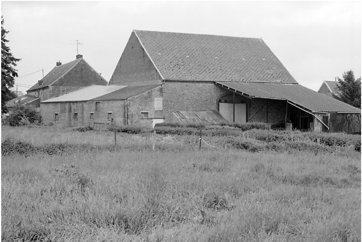
Vue de l'élévation postérieure de la grange et des étables.
