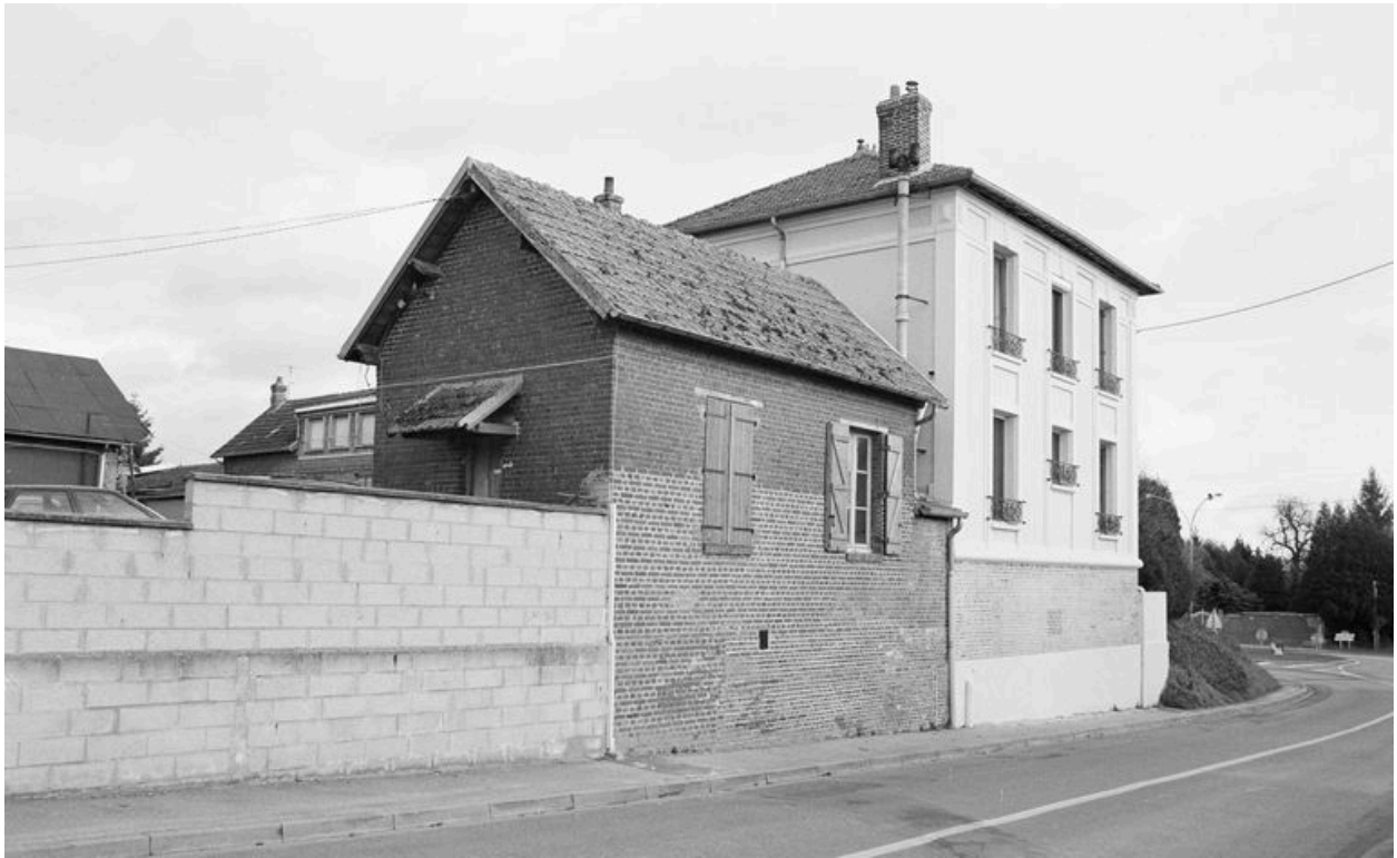
Réception et logement patronal : façade sur rue.
