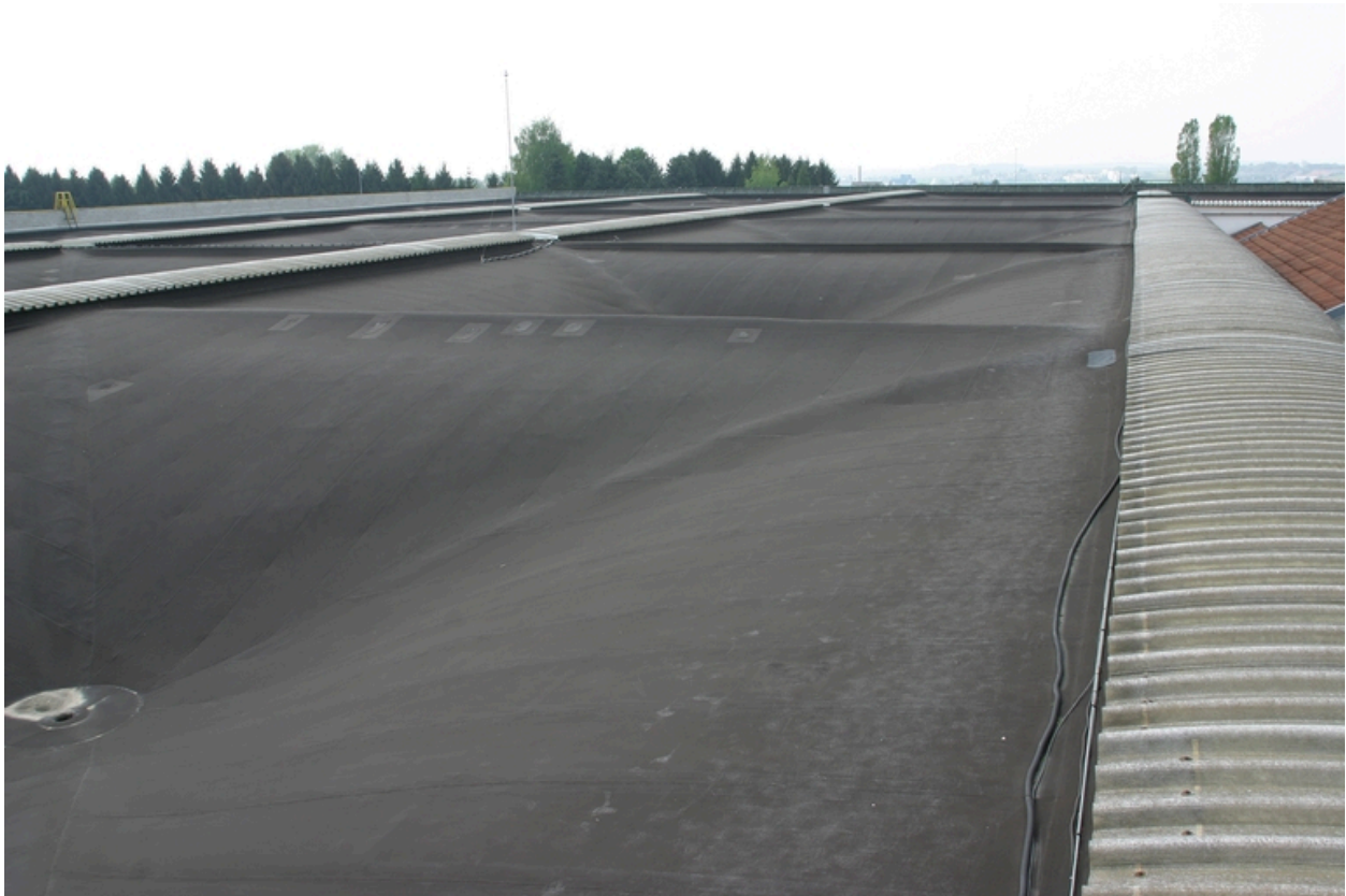
Toiture des entrepôts et magasins de 1966.
