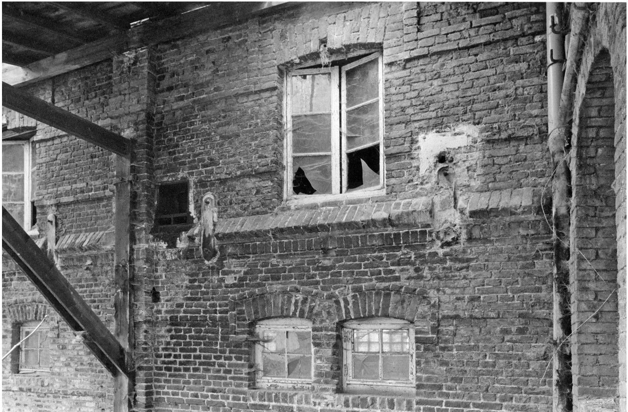
Ancrages sur la cour de l'axe de transmission de la malterie.
