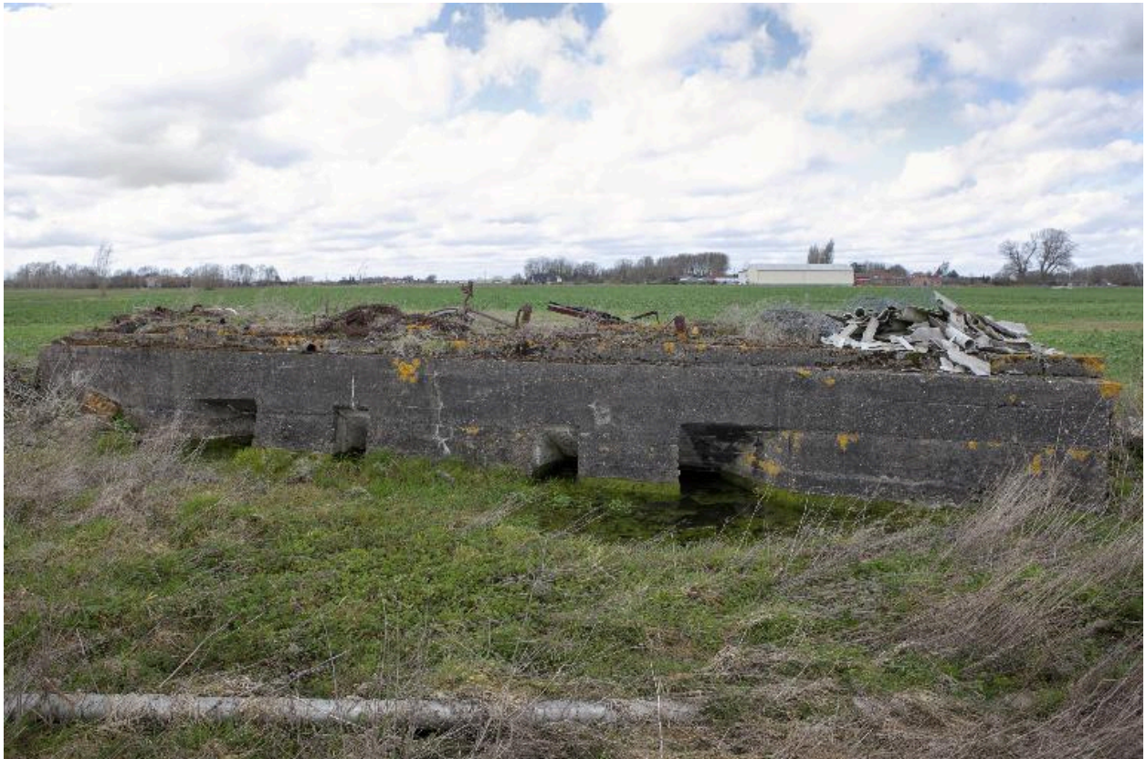
Élévation antérieure (sud-est). On aperçoit les entrées latérales et les resserses à mitrailleuses
