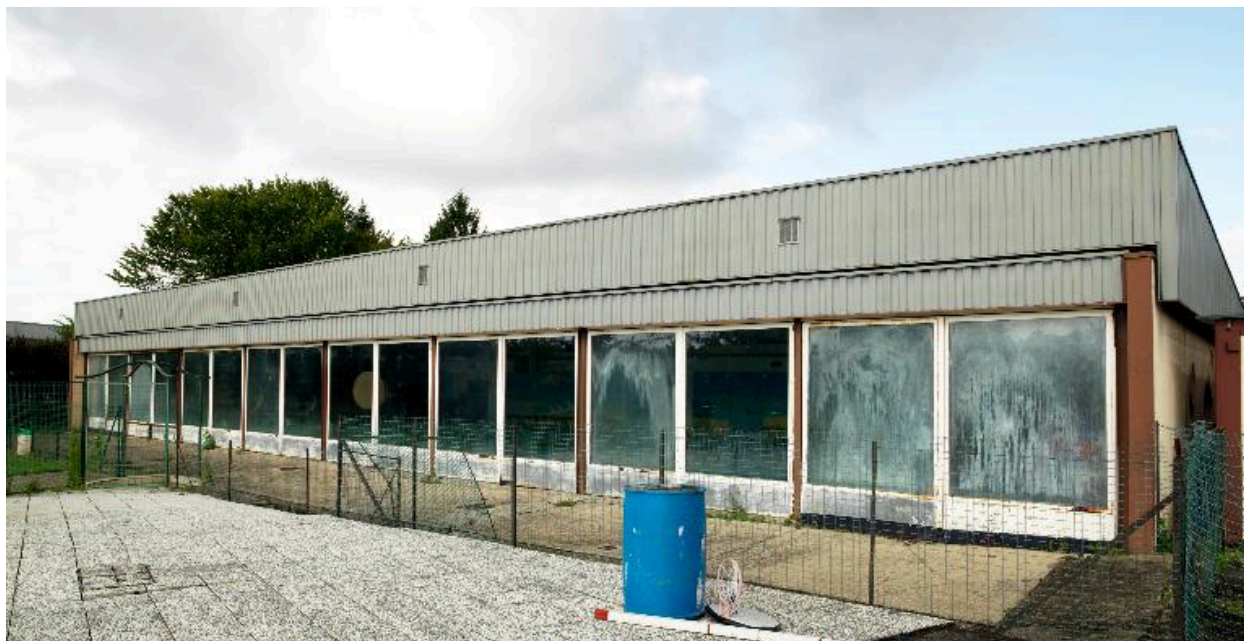
Façade sud et terrasse-solarium.
