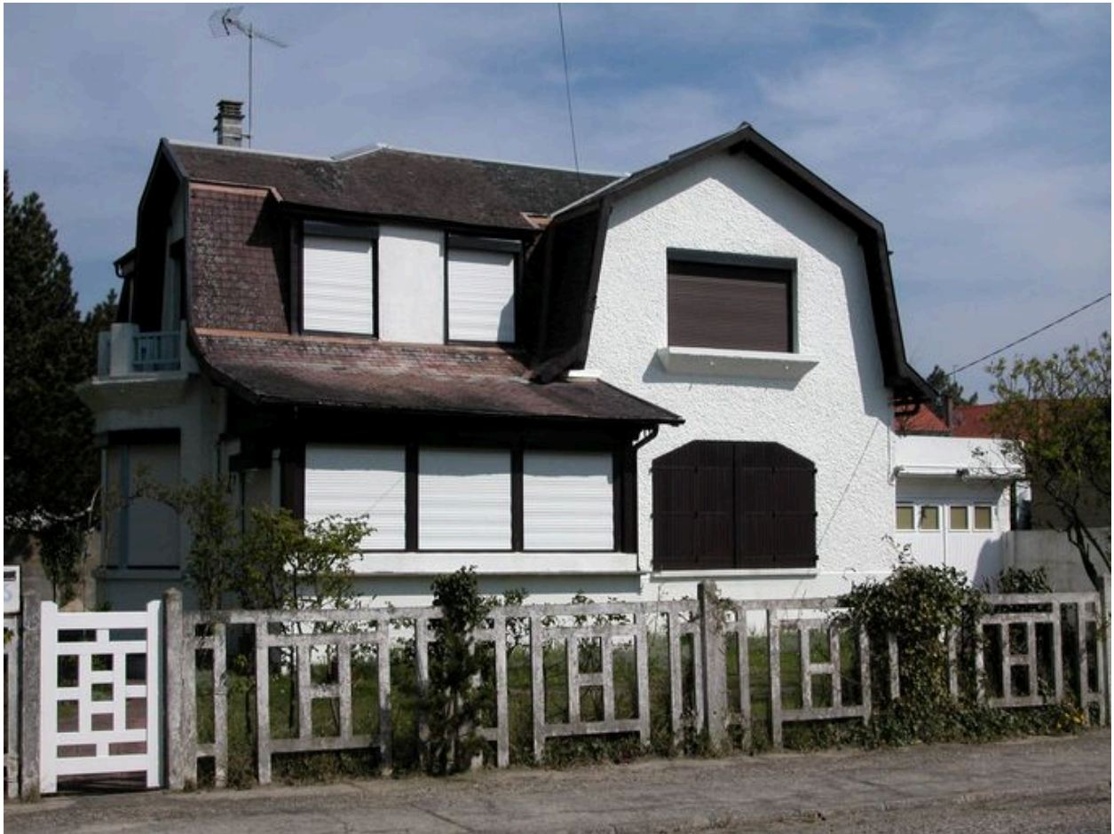
Elévation antérieure, vue rapprochée.
