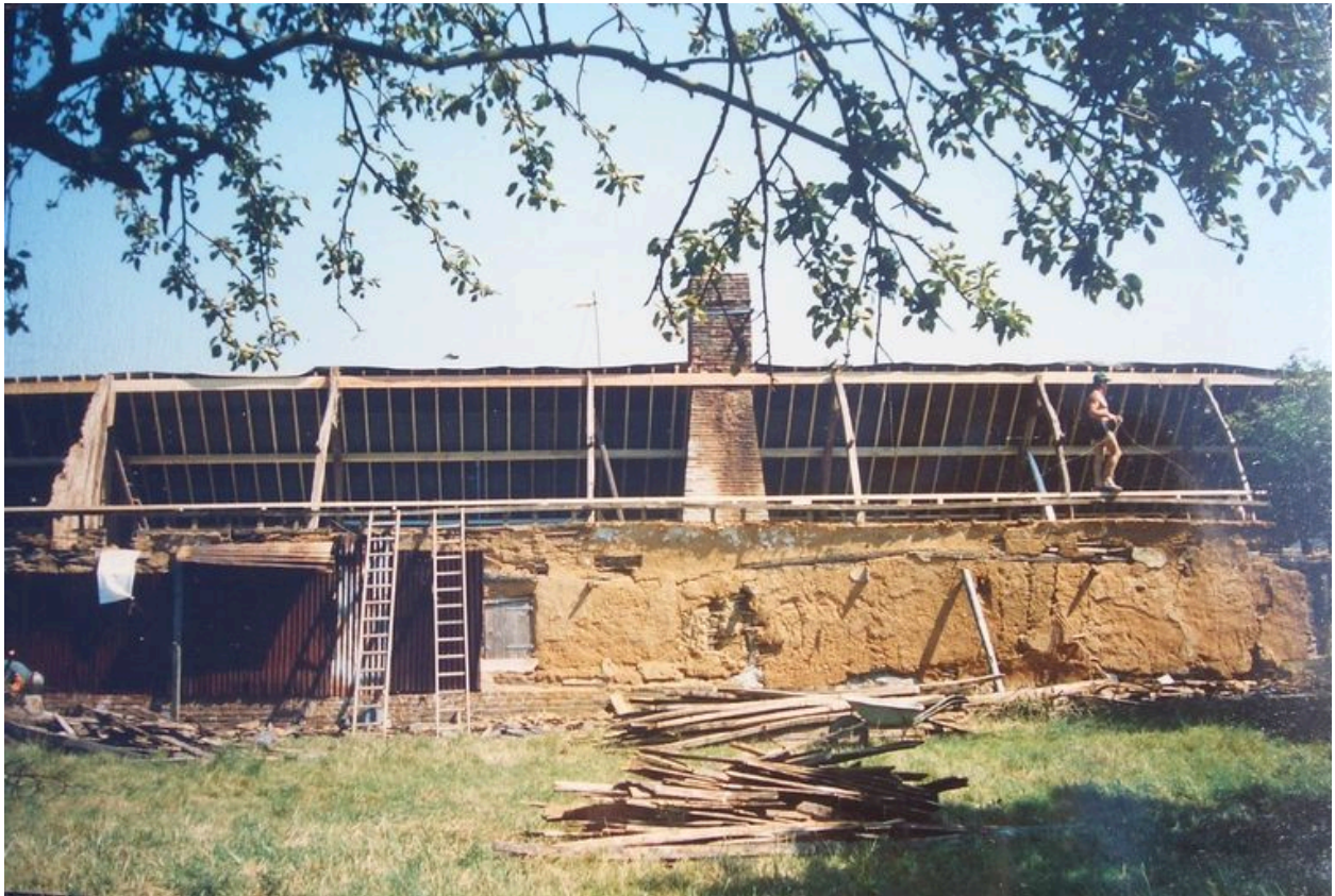
Vue postérieure du logis.
