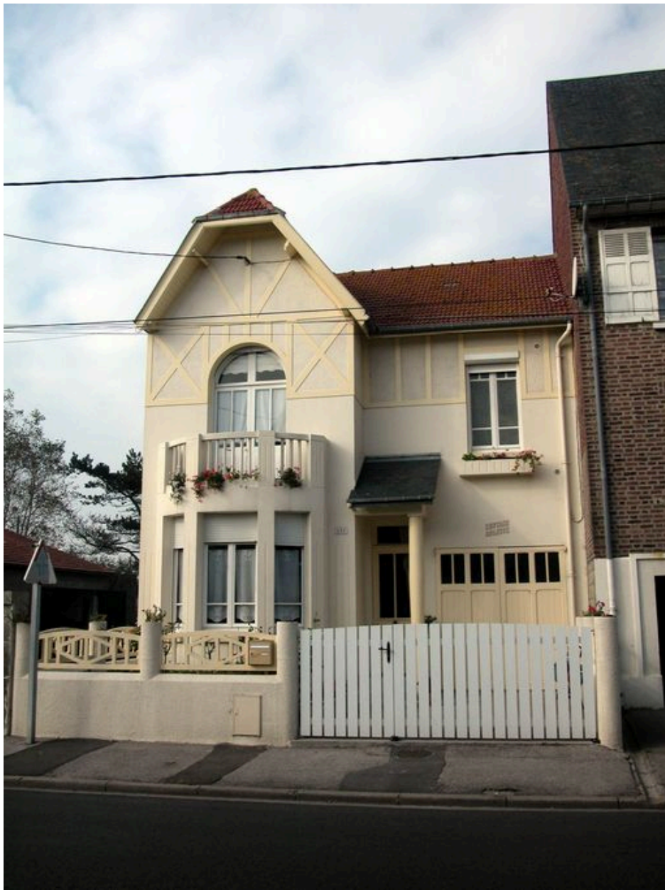
Le motif du faux pan de bois en ciment, Cottage Arlette, 132 rue du Maréchal-Foch (1988 AY 162).
