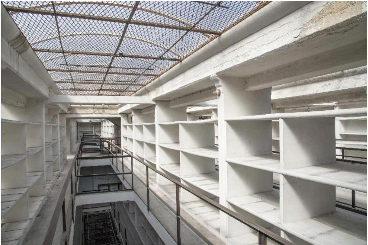
Bâtiment du dépôt, troisième étage : vue du vaisseau 3 vers l'ouest.
