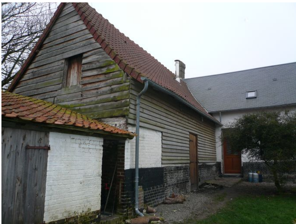
Vue de l'étable depuis la cour postérieure.
