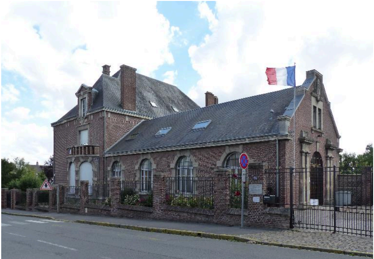
Vue depuis le nord.
