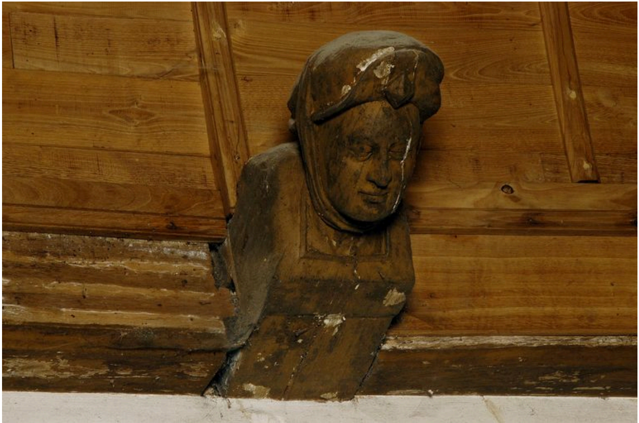
Vue intérieure : détail d'un blochet de la nef.
