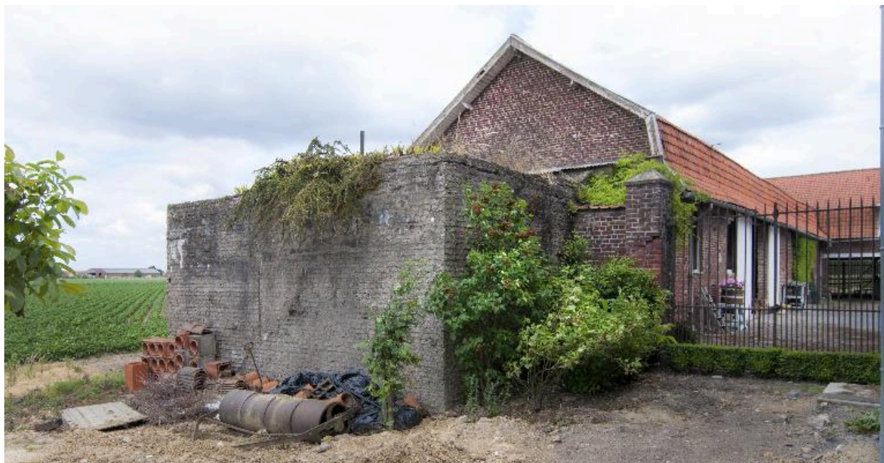
Casemate B, vue de trois-quarts vers 3 sud-est
