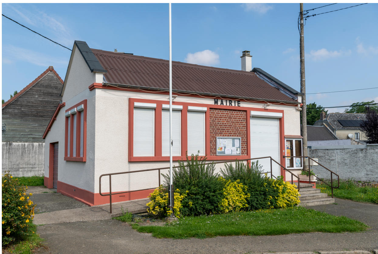
Mairie, rue de la Mairie, vue depuis le sud.
