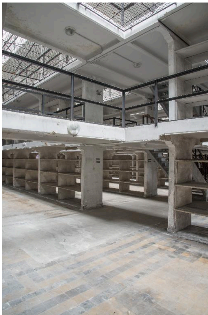
Bâtiment du dépôt, rez-de-chaussée : vue du vaisseau 4 vers le nord ouest.
