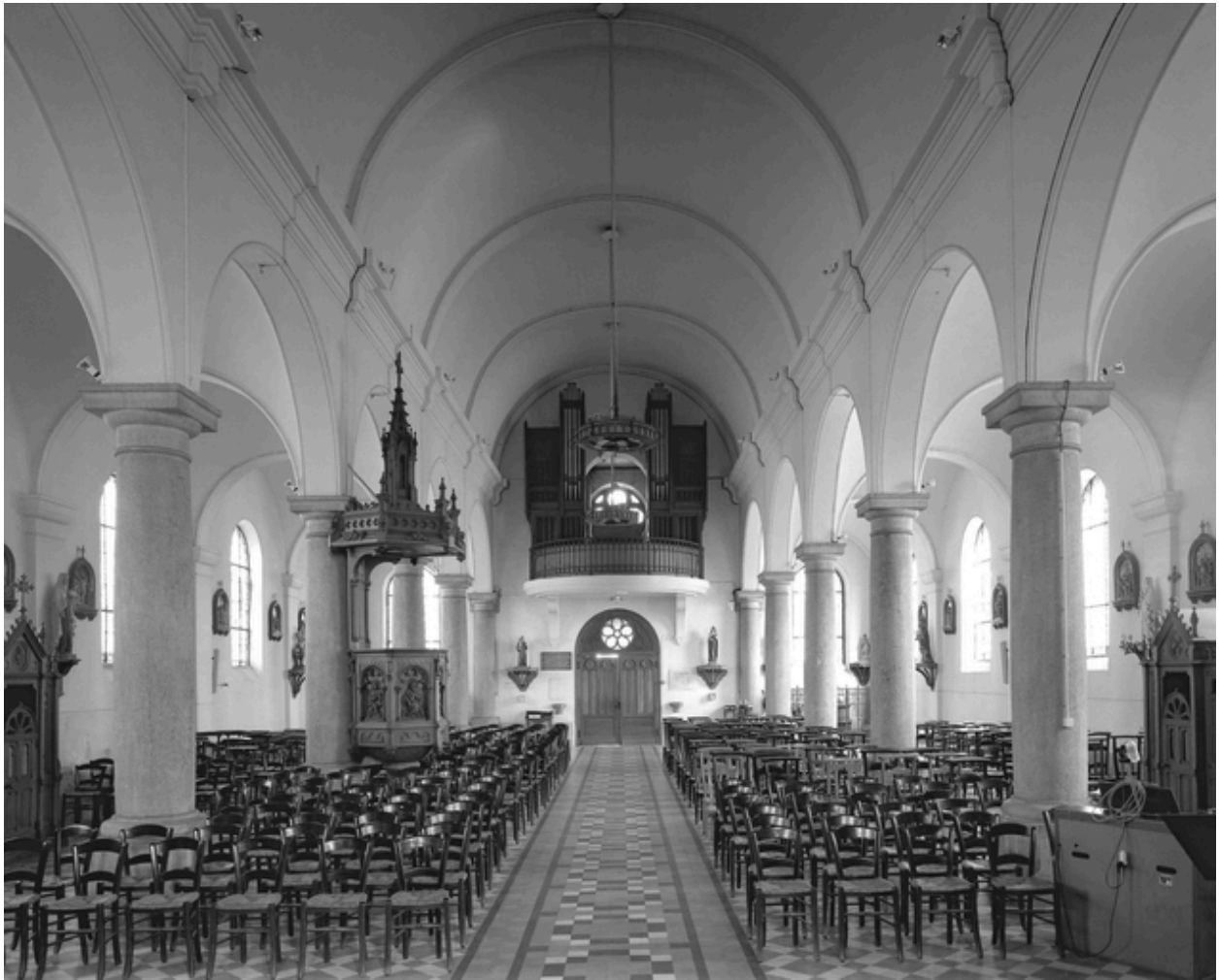
Vue générale intérieure vers l'entrée.
