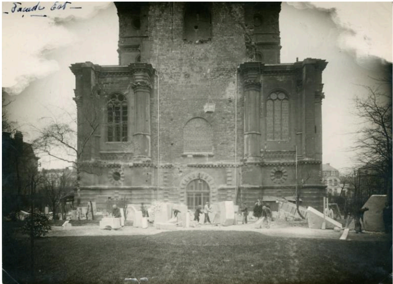
Ouvriers dans le jardin public travaillant à la restauration de la tour de l'abbaye, photographie, années 1930 (Musée municipal Saint-Amand-les-Eaux).
