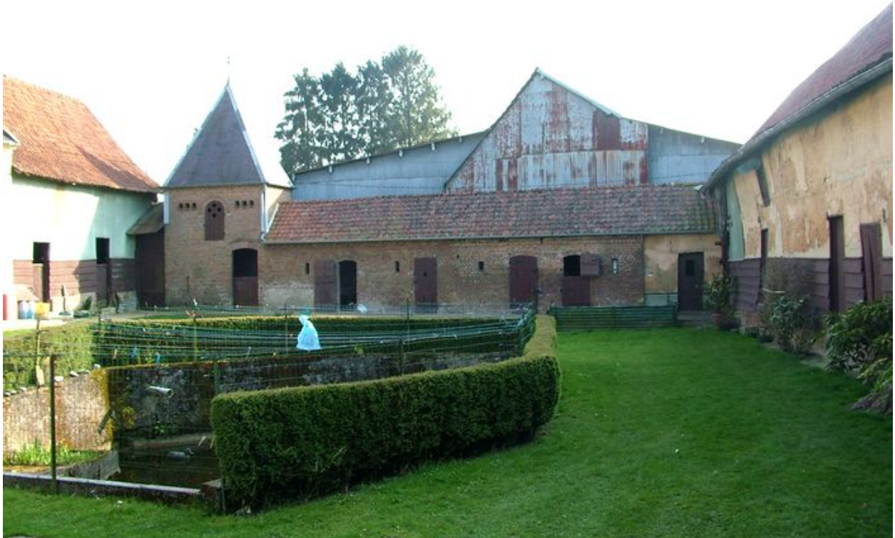
Vue du colombier et de la porcherie en fond de cour, avec le pédiluve au premier plan.
