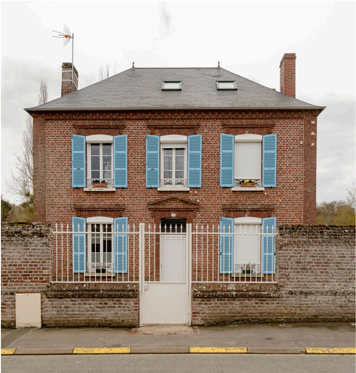
Ancien presbytère, n°153 rue de l'Église, vue prise depuis le nord.
