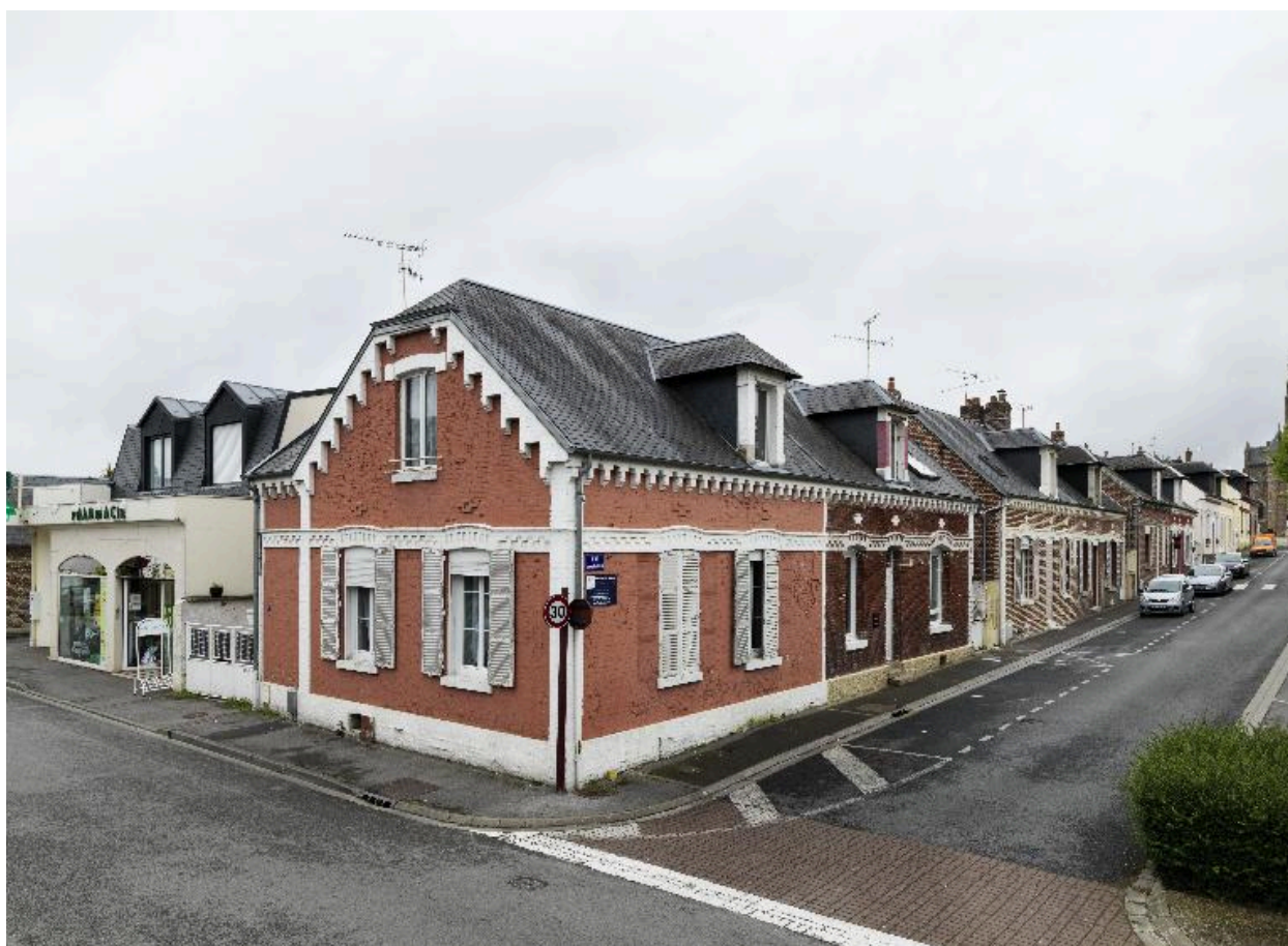
Vue d'ensemble de l'ancienne cité Maguin, rue Alfred Maguin.
