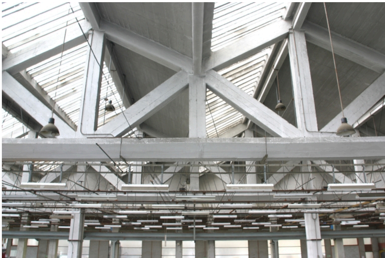
Vue intérieure des ateliers de 1949 : détail de la charpente.
