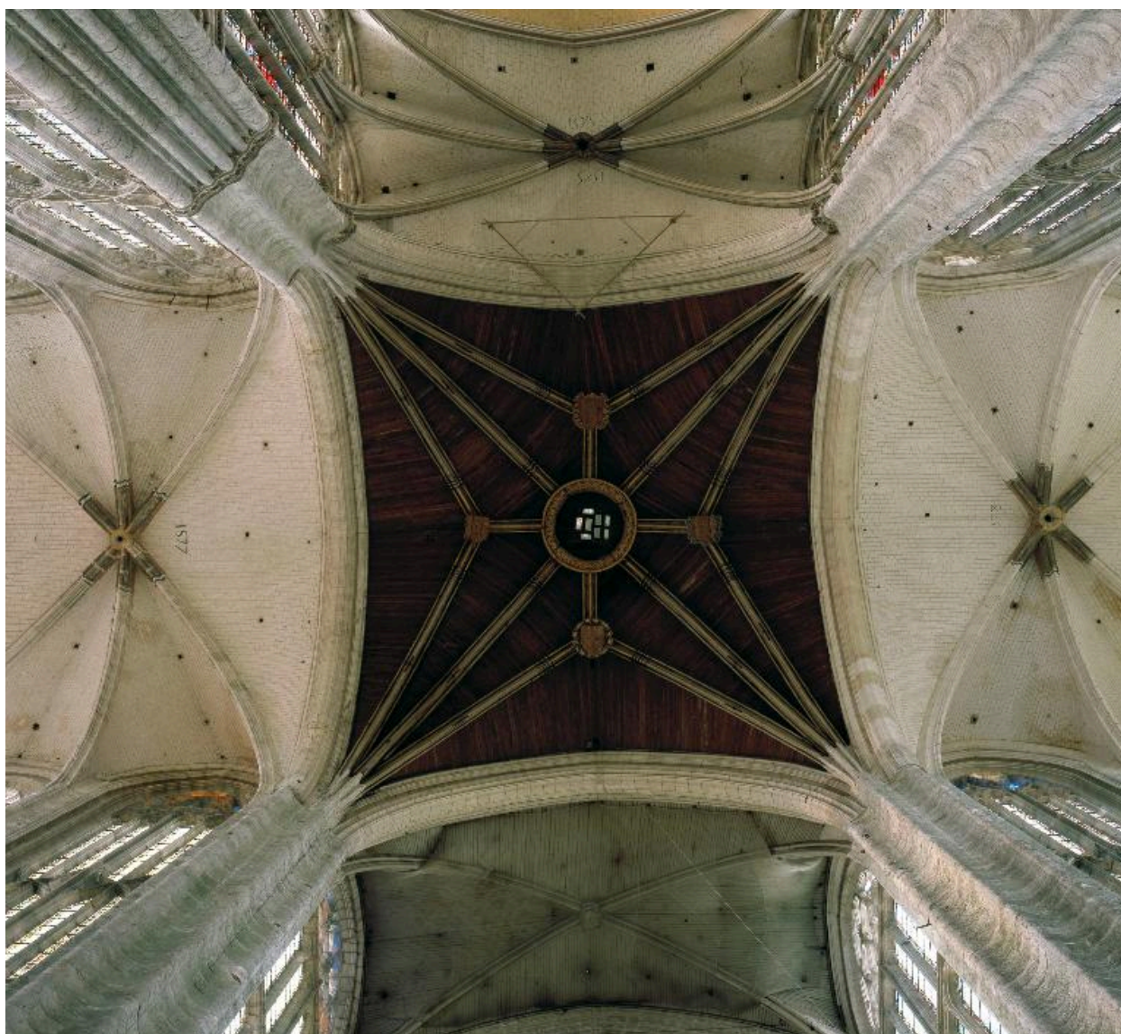
Vue du couvrement de la croisée.
